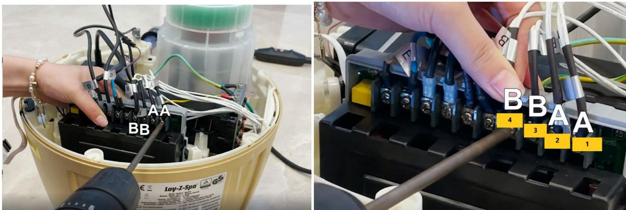
23. Branchez le câble noir en appuyant sur la languette du connecteur femelle blanc et en insérant le connecteur mâle blanc ; faites de même avec le connecteur rouge à fil unique et le connecteur blanc à fils multiples.
